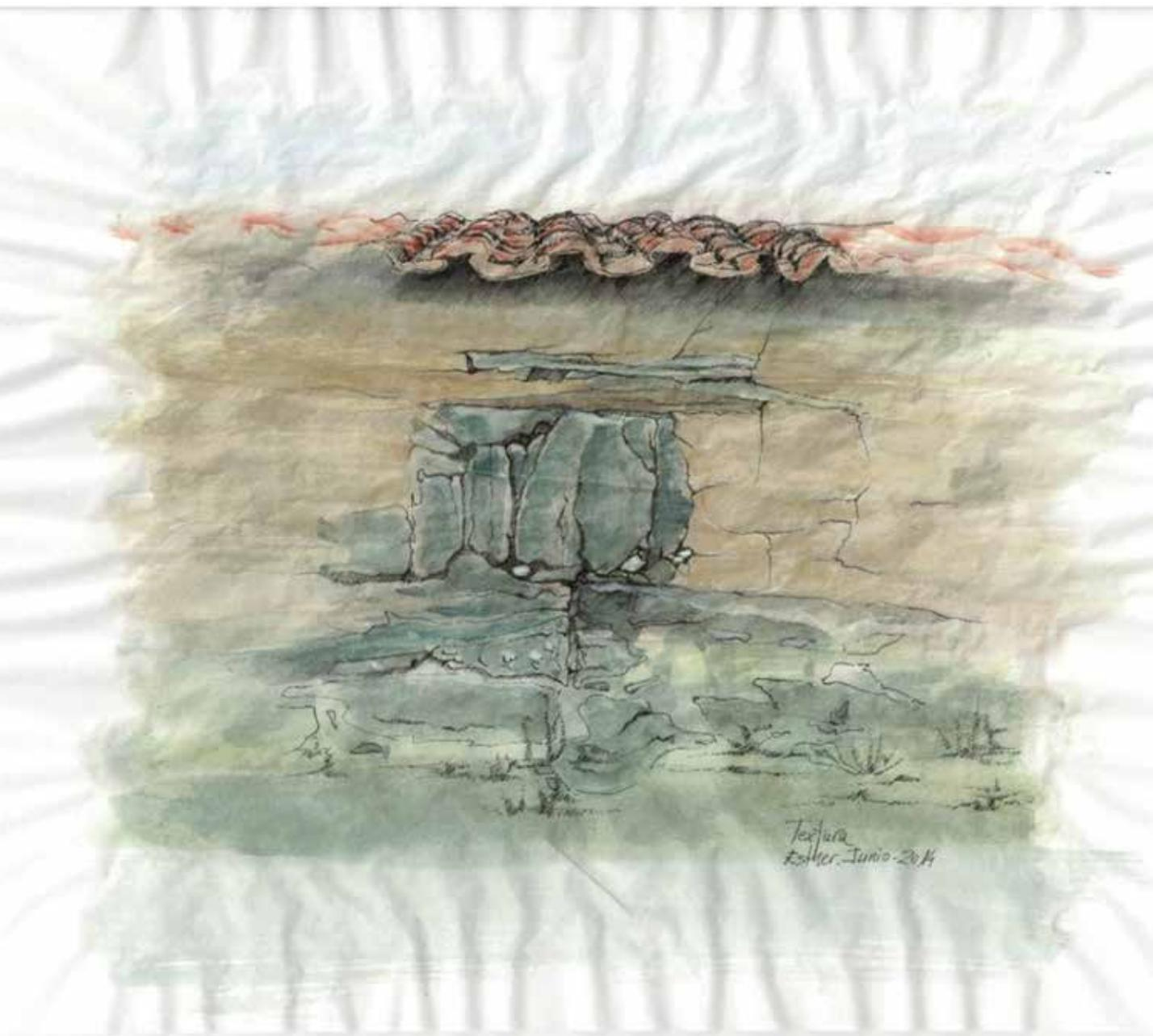
Textura de fachada. Antigua casa de pastor en Sayago con un boquero cegado. Materiales: zócalo de granito, muro de adobe y tapial, cargadero de madera y teja árabe. Dibujo a tinta y acuarela. E. Prada.
