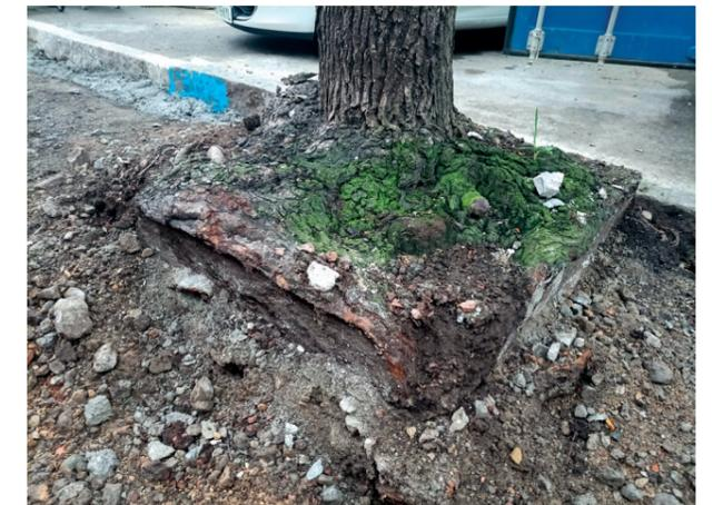
El sistema Estocolmo consiste en generar un suelo artificial permeable de 1,30 m de profundidad formado por capas de diversa granulometría y ecoáridos
