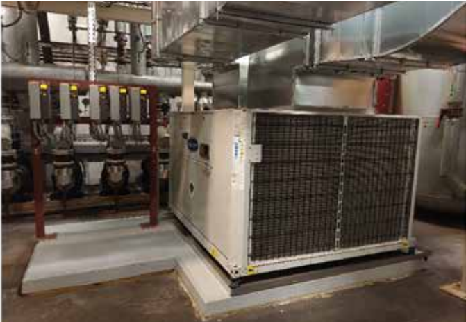
Unidades motobombas con variadores de frecuencia y nueva bomba de calor para producción de ACS en sustitución de caldera.
