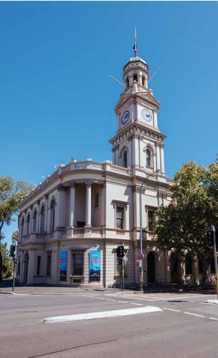
En las semicubiertas del Paddington Town Hall en Oxford Street, Sydney (Nueva Gales del Sur, Australia) se han situado paneles solares no visibles
