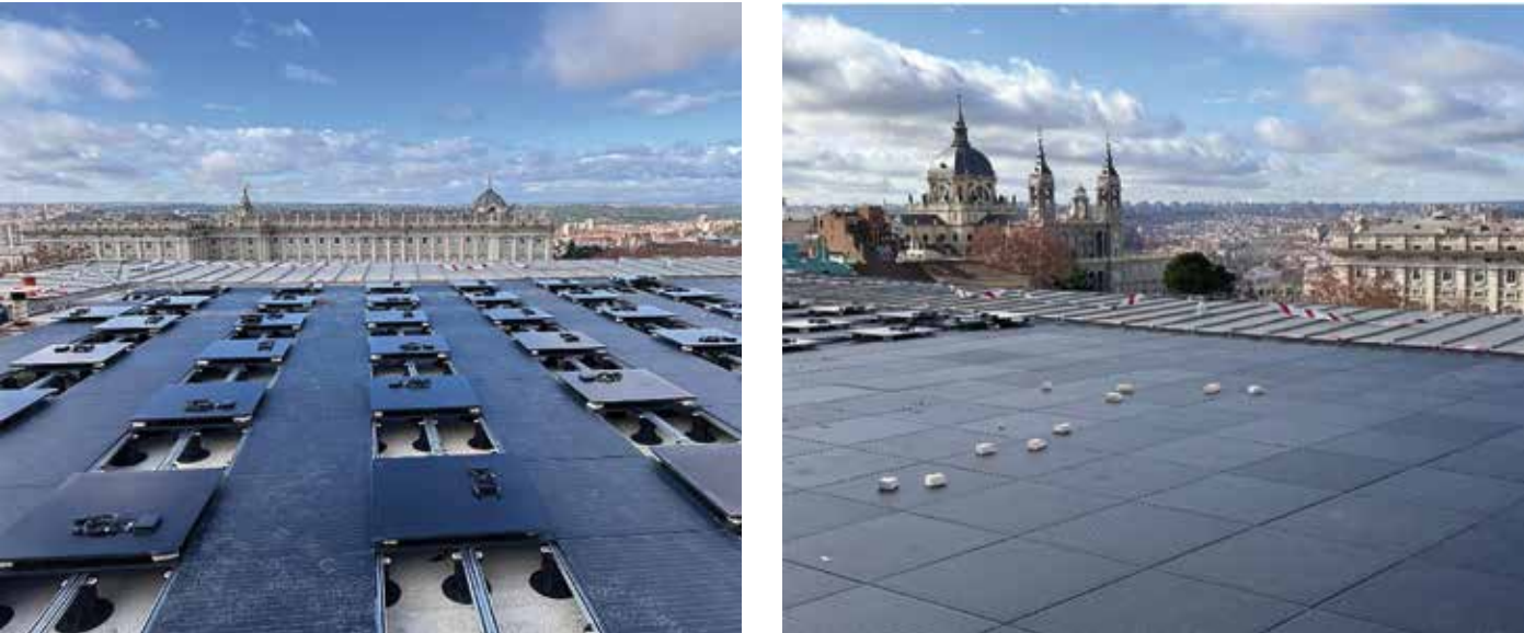
Implantación de pavimento de vidrio solar pisable fotovoltaico en las cubiertas de Coro, Sepe y Gayarre.
