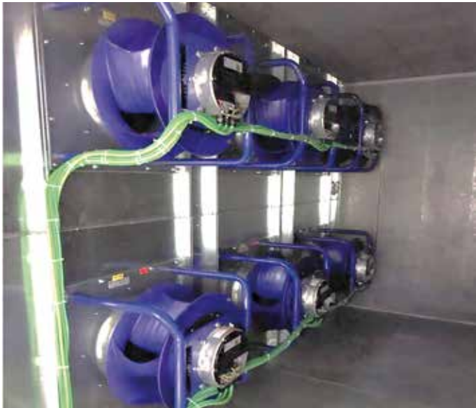
Ventiladores con motores de alta eficiencia IE5.
