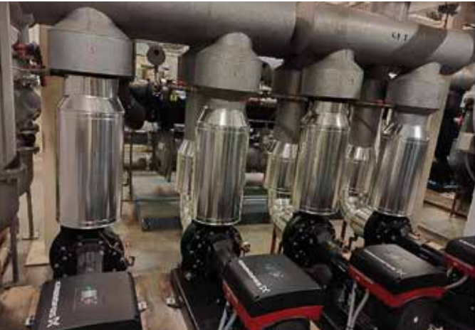
Unidades motobombas con variadores de frecuencia y nueva bomba de calor para producción de ACS en sustitución de caldera.
