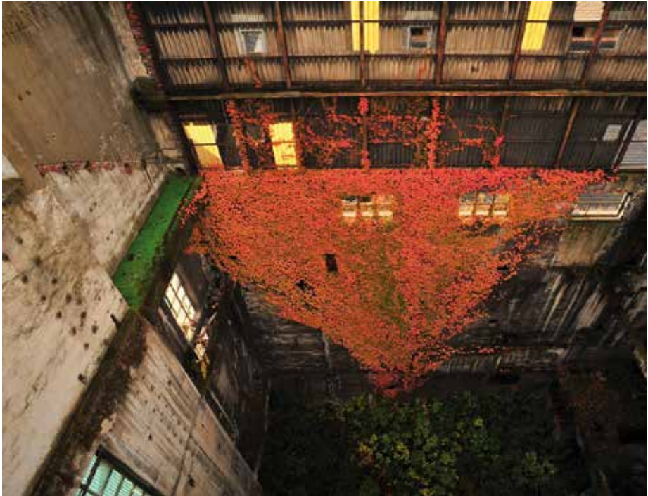
Nave de Calderas de La Térmica Cultural antes de la rehabilitación.
