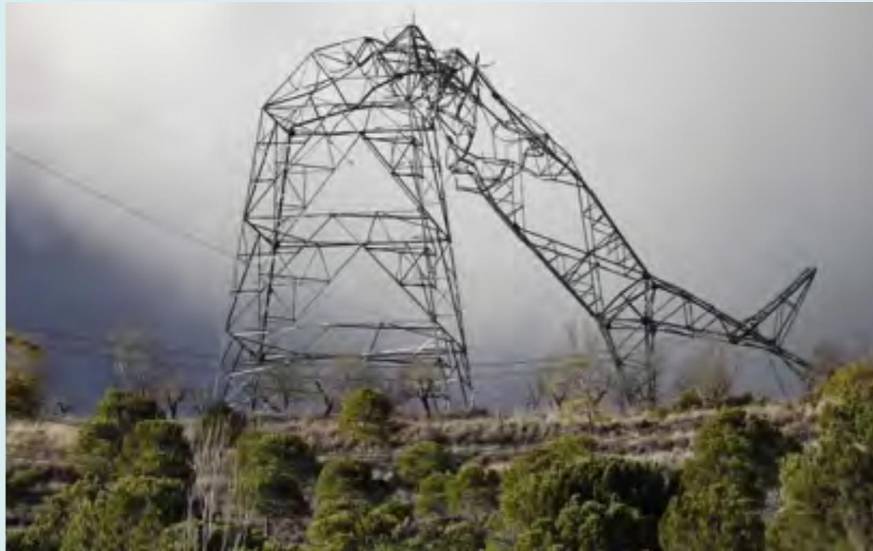
**Los vientos muy intensos que superan los parámetros para los que están diseñados los apoyos pueden provocar daños en las estructuras, que en casos extremos pueden derivar en afecciones al suministro eléctrico.**
