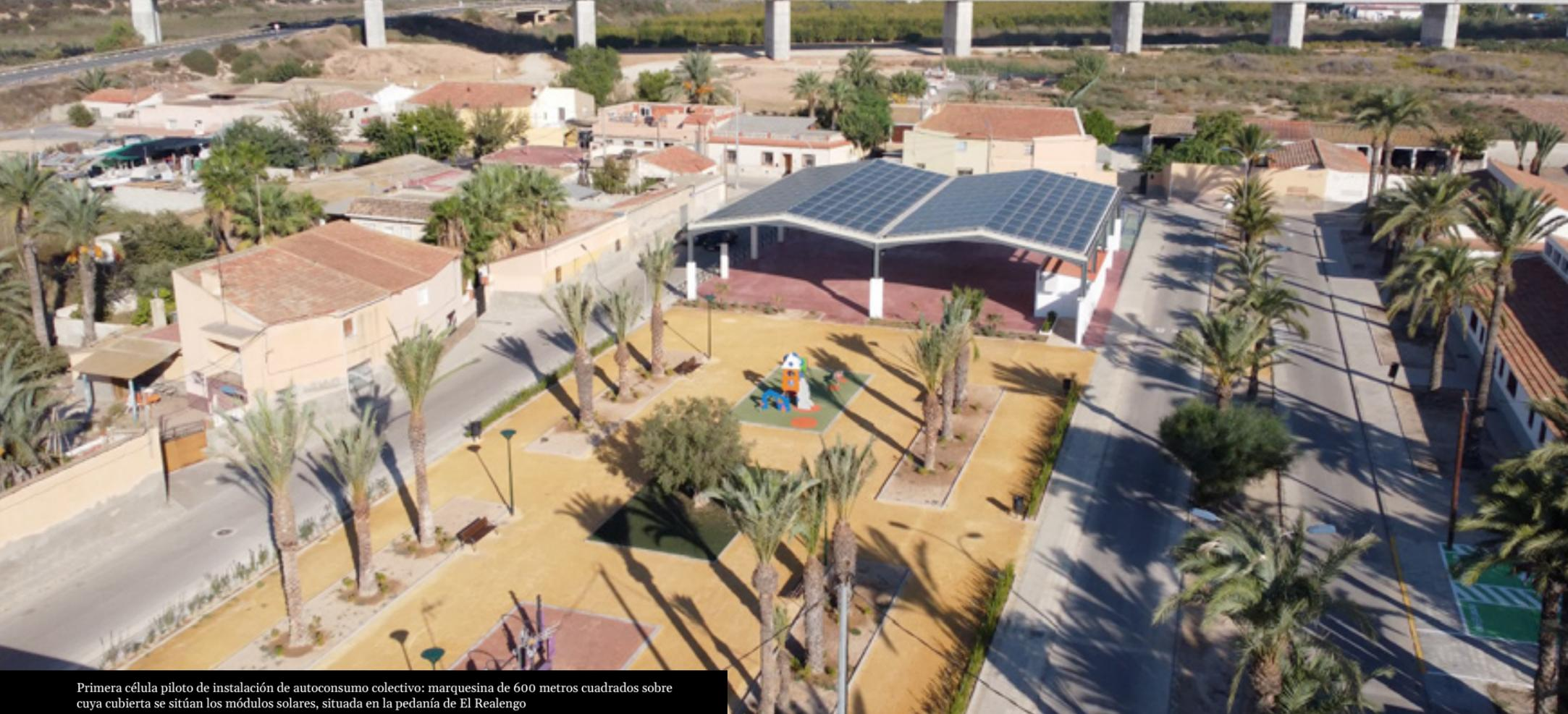
Primera célula piloto de instalación de autoconsumo colectivo: marquesina de 600 metros cuadrados sobre cuya cubierta se sitúan los módulos solares, situada en la pedanía de El Realengo
