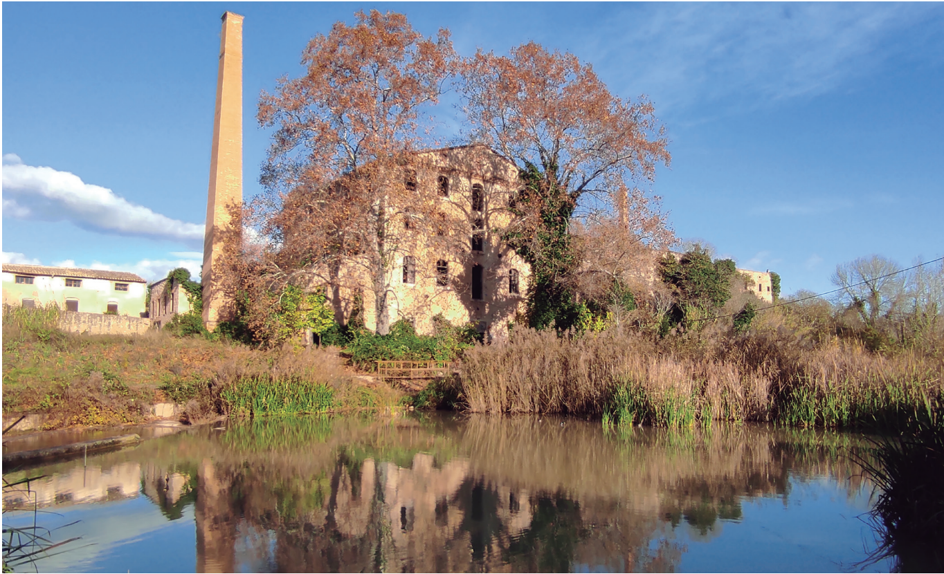
Tramo en restauración del río Gaià a su paso por la resclosa d’el Catllar (Tarragona) © J.Cortina
