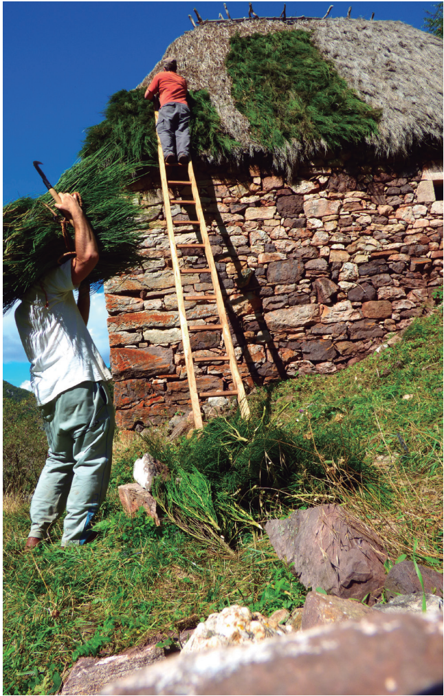
Restauración con cubierta vegetal del tejado de un techo © AFA
