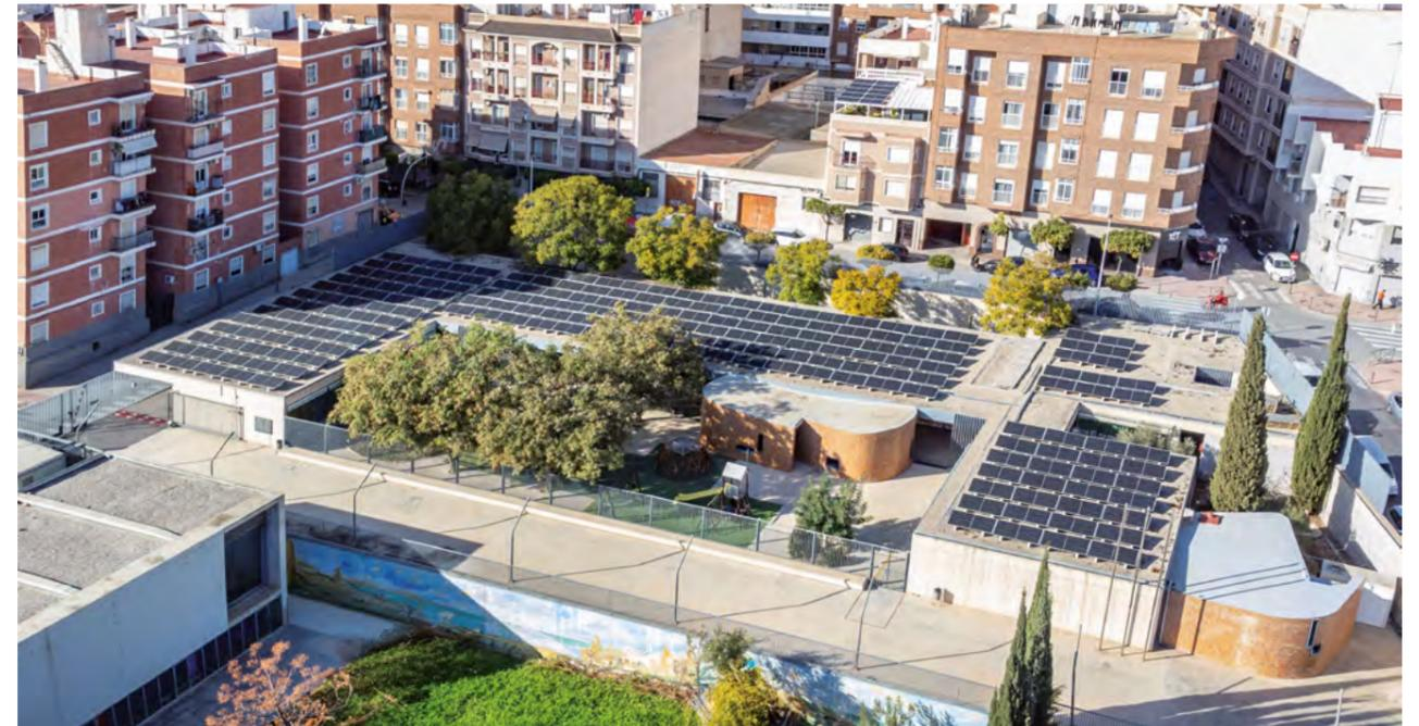
Instalación de autoconsumo colectivo de COMPTEMEnercoop en CEIP Pilar Ruiz de Crevillent, 117 kWp
