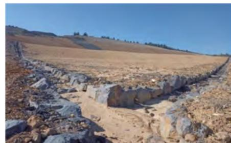
Imagen técnica A. Detalle de la red de drenaje mediante canales y bajantes elaborados con material pétreo de la zona
