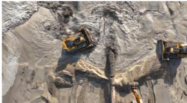
La tubería conectada a la draga aportando material y maquinaria pesada ampliando la playa
