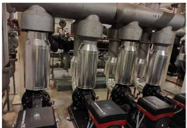
Unidades motobombas con variadores de frecuencia y nueva bomba de calor para producción de ACS en sustitución de caldera.
