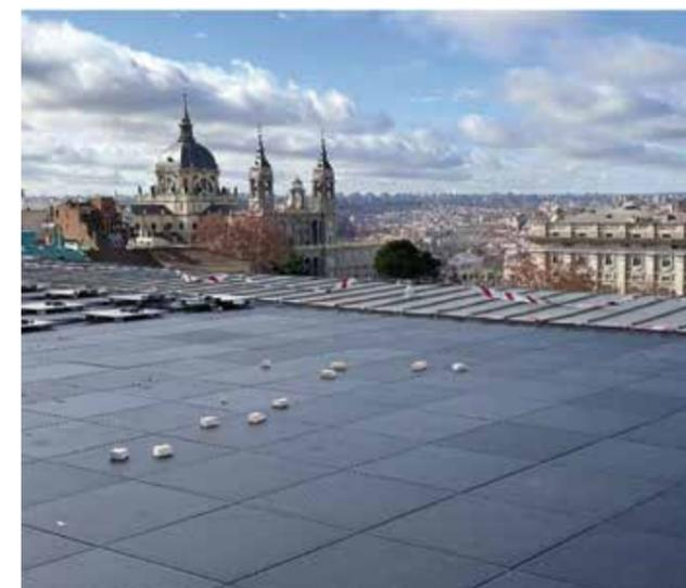
Implantación de pavimento de vidrio solar pisable fotovoltaico en las cubiertas de Coro, Sepe y Gayarre.
