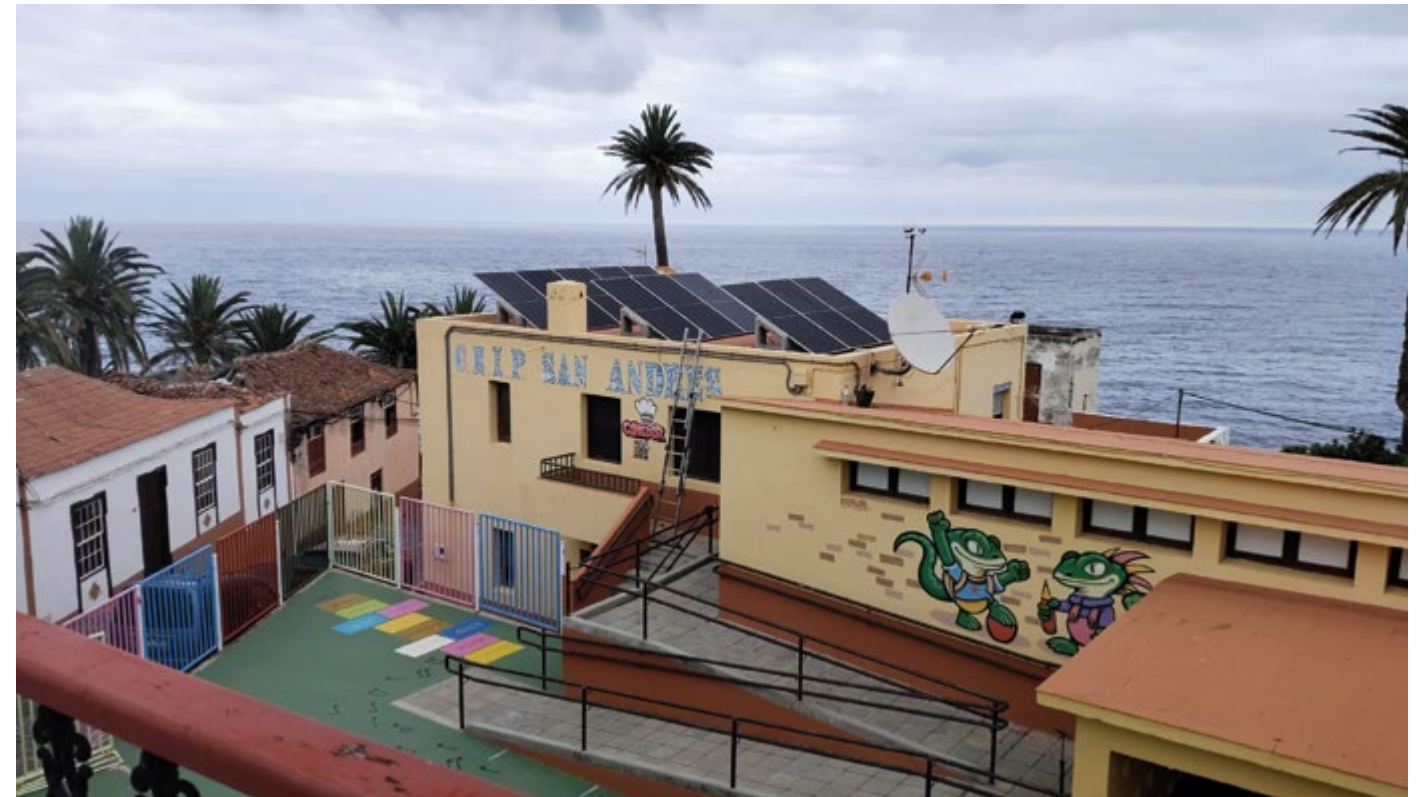
Instalaciones fotovoltaicas en centros escolares.
