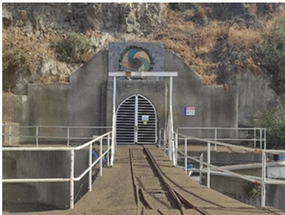
Túnel del Trasvase ejecutado por la Dirección General de Aguas del Gobierno de Canarias.
