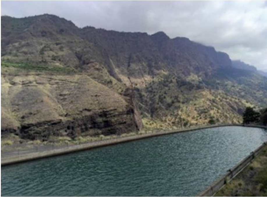
Balsa de recogida de escorrentía del barranco de Las Angustias.
