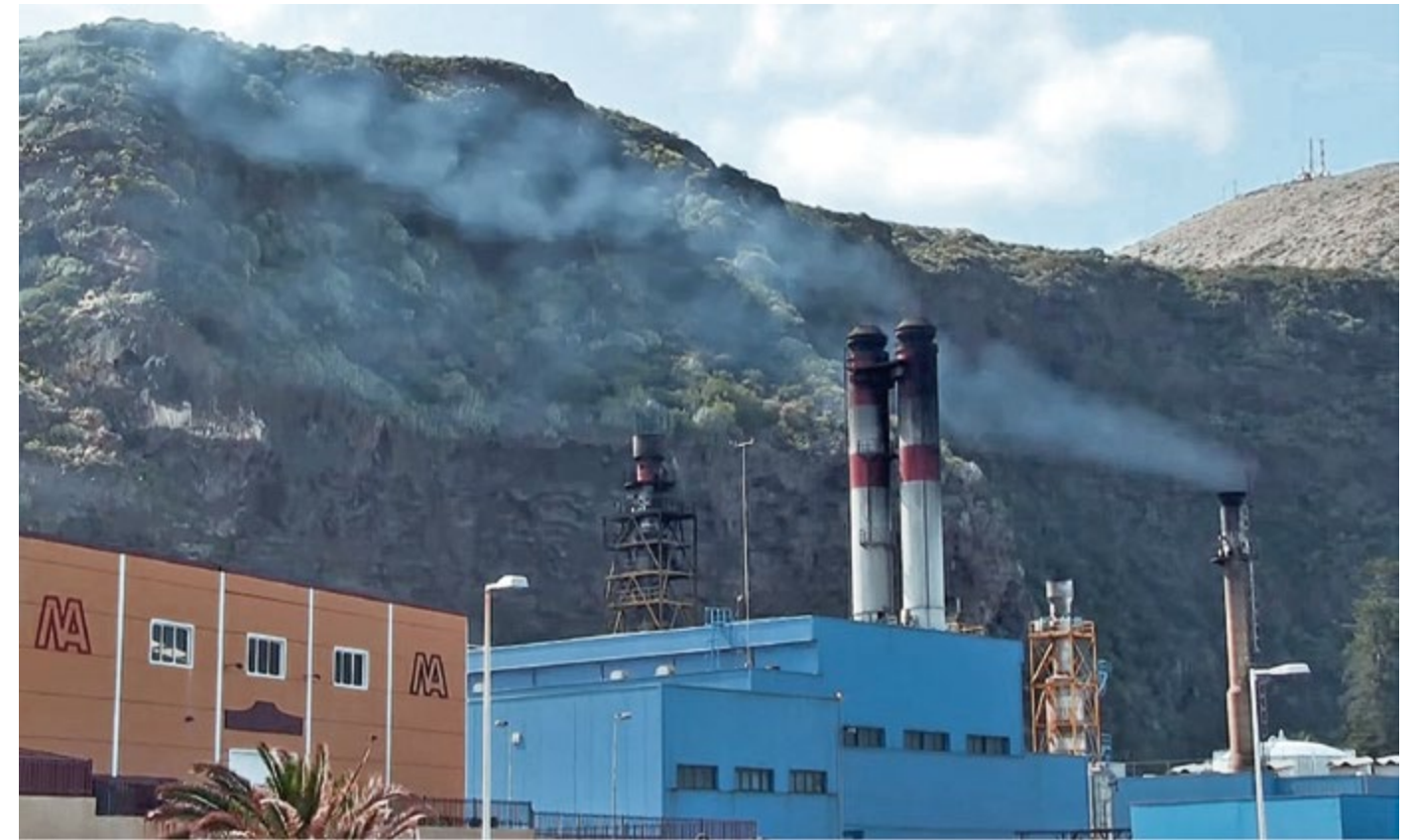
Central térmica de Los Guinchos © Archivo Terabithia.
