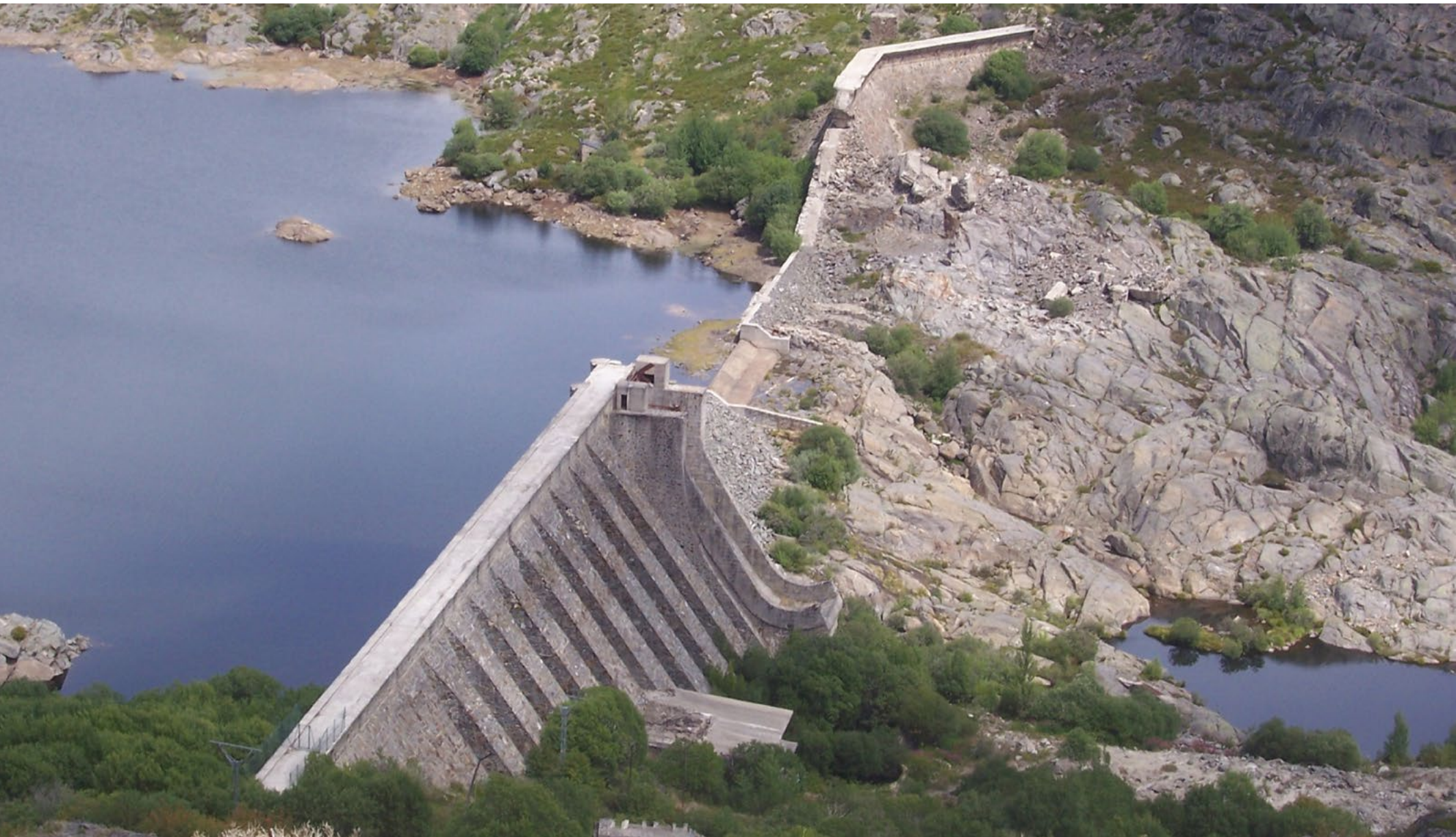
Pres a de Vega del Tera con la rotura en el muro © José Antonio Collazo.
