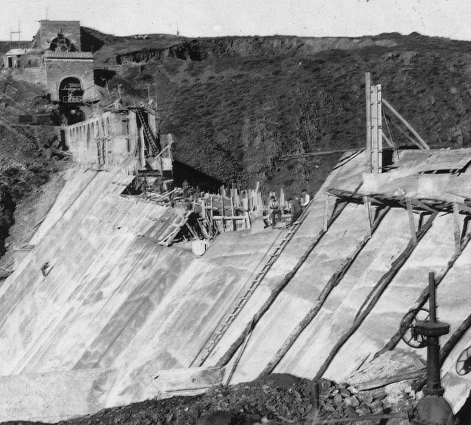
Construcción de la presa de Villameca © CHD.
