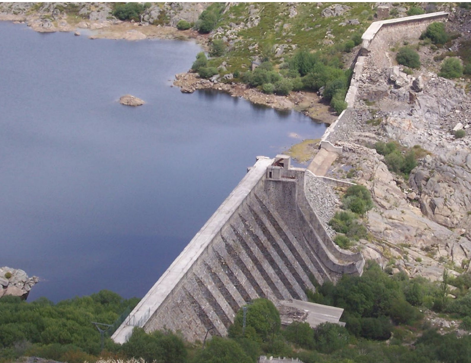
Presa de Vega del Tera con la rotura en el muro © José Antonio Collazo.
