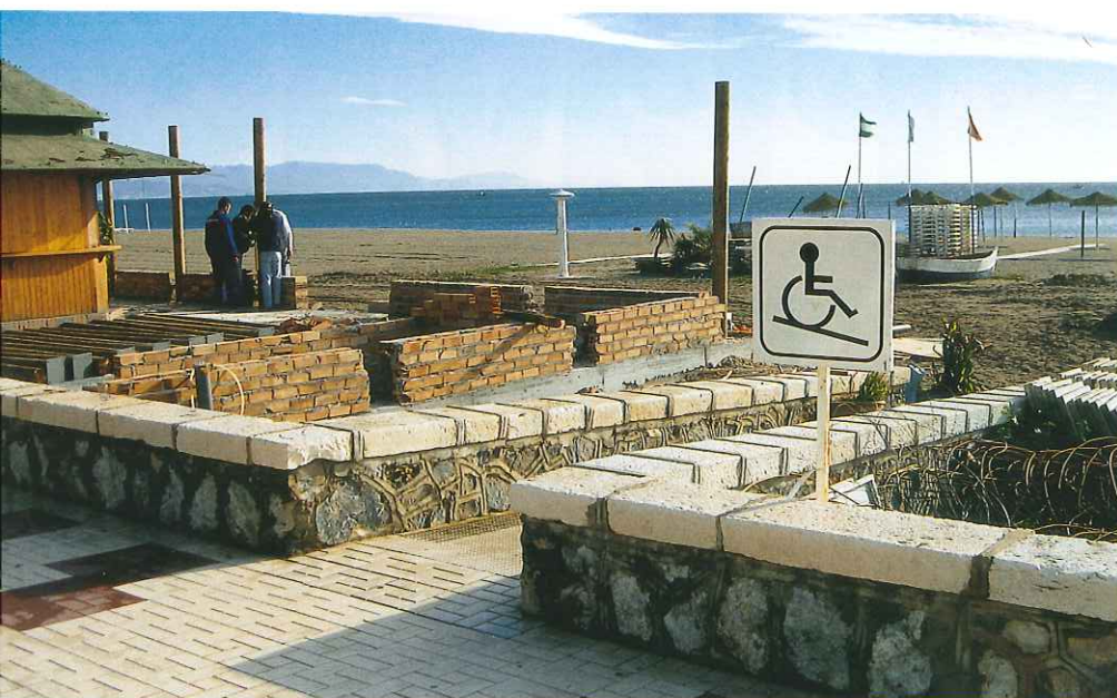
■ Acceso peatonal. Playa de la Barrosa. Chiclana de la Frontera.
