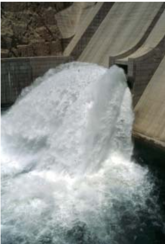
Aliviadero de la presa del Negratín.
