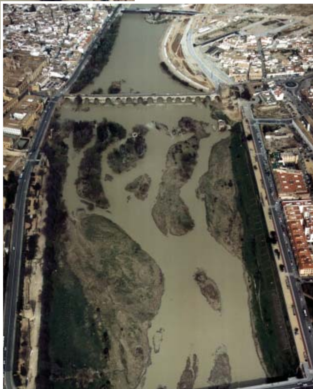
Sotos de La Albolafia y Puente Romano. Situación de la Obra en marzo de 2003.
