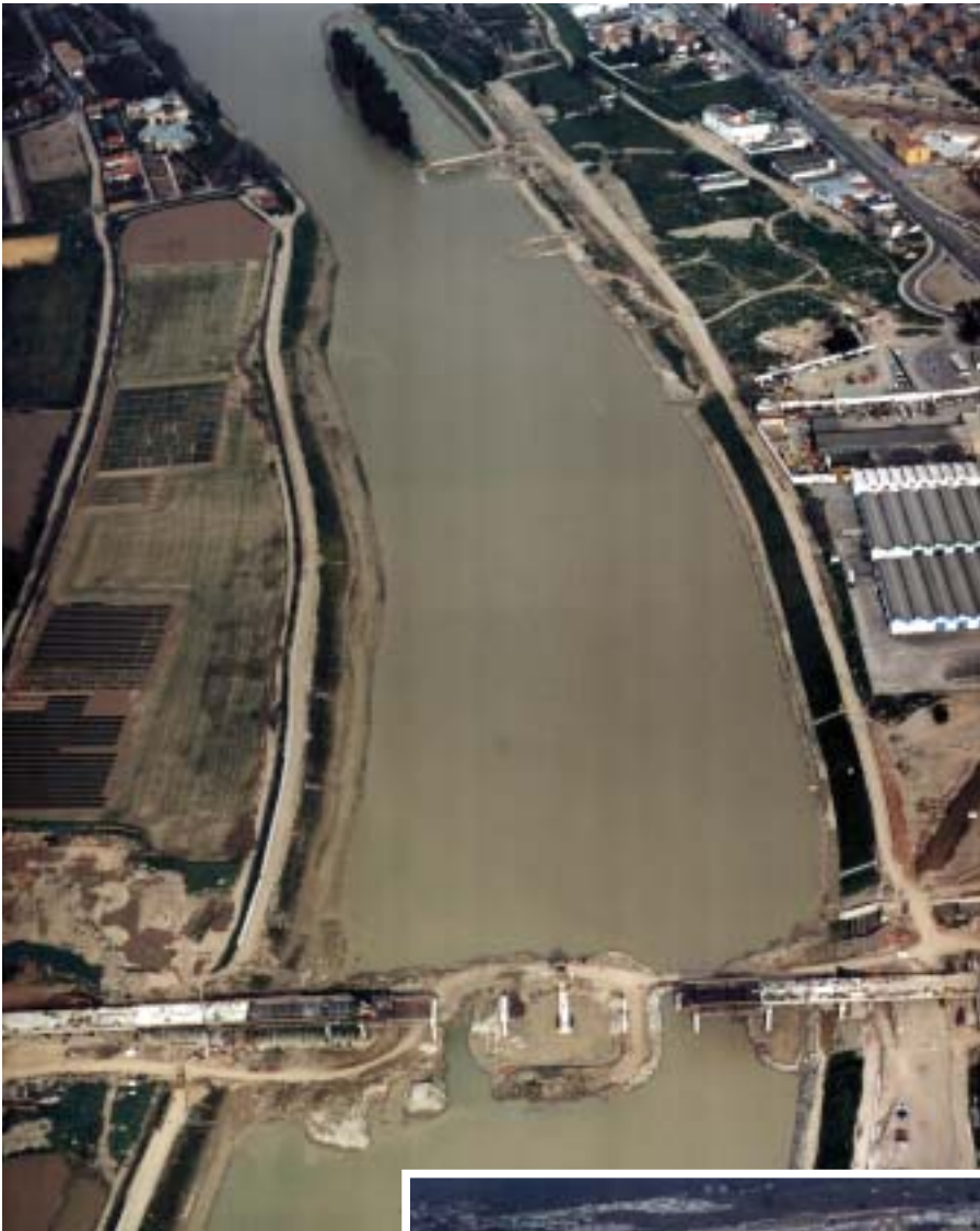
Polígono Industrial La Torrecilla y puente de Andalucía.
