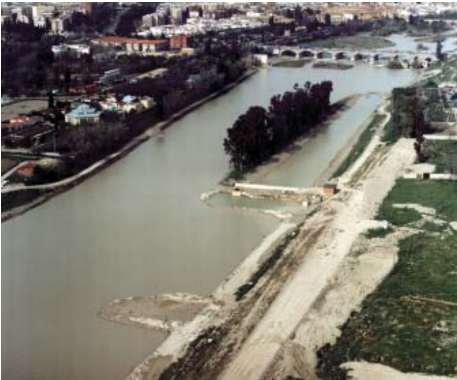
Obras accesorias. Embarcadero y reposición de alcantarillado.
