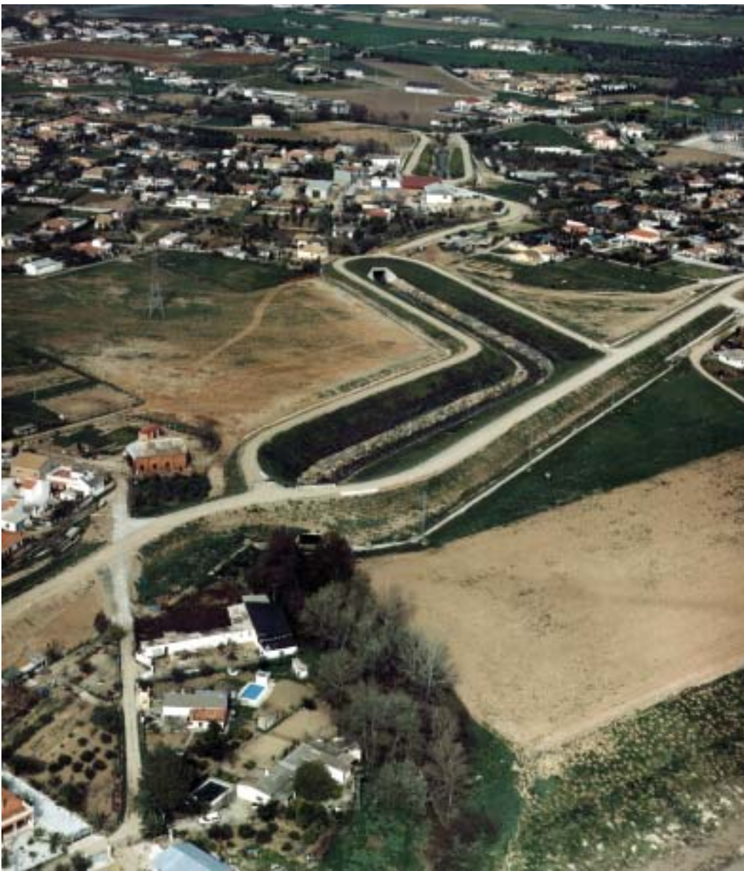
Encauzamiento arroyo Cantarranas.
