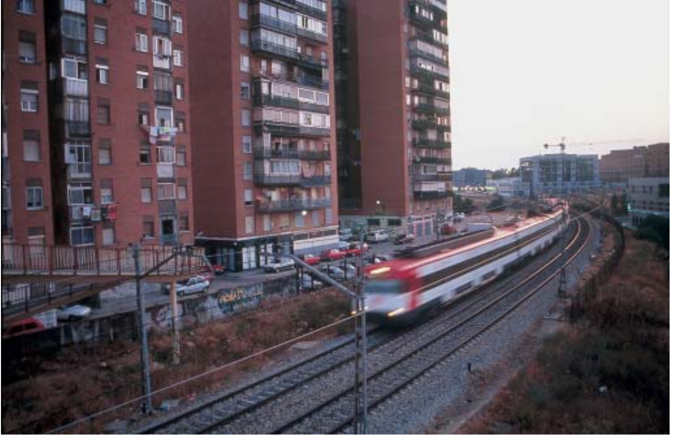
Con la implantación de la edificación sostenible se evitarán construcciones como esta.
