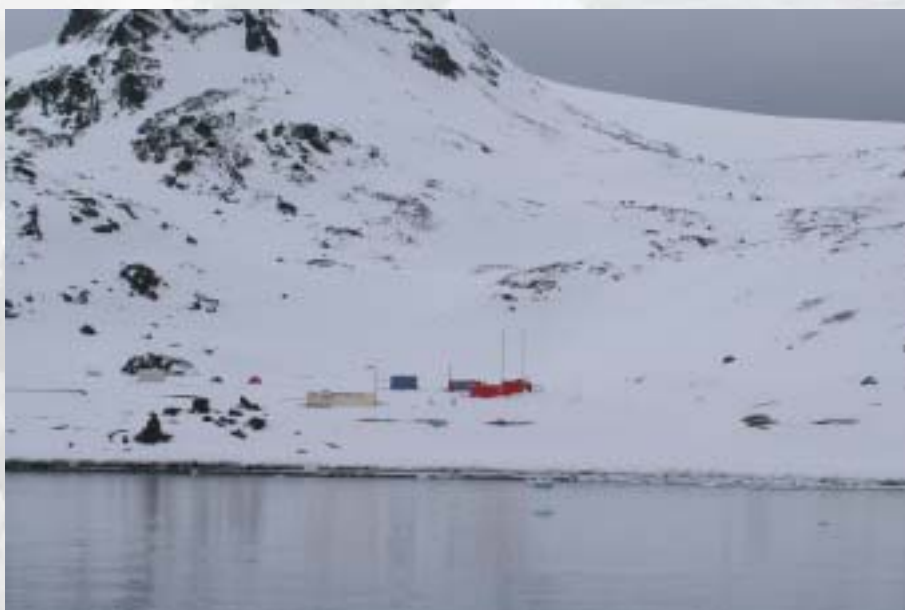
El edificio rojo es la BAE y la construcción adyacente es el lugar donde se ubican los ordenadores y equipos diversos.
