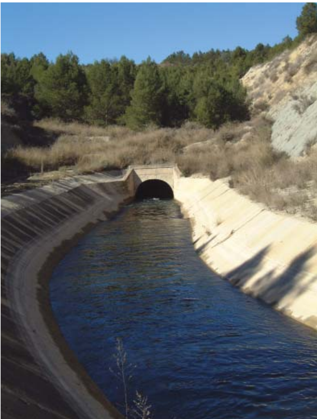
Túnel del canal del post-trasvase Tajo-Segura .
