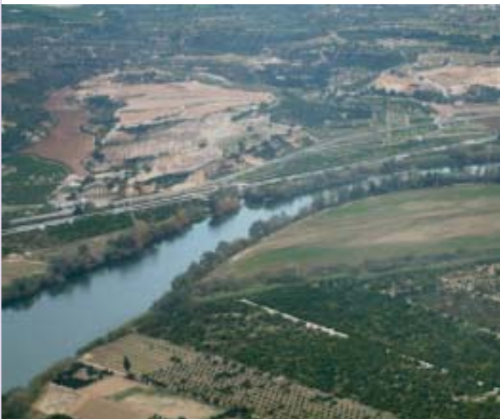
Ubicación de la toma en Tortosa desde la margen izquierda del Ebro.
