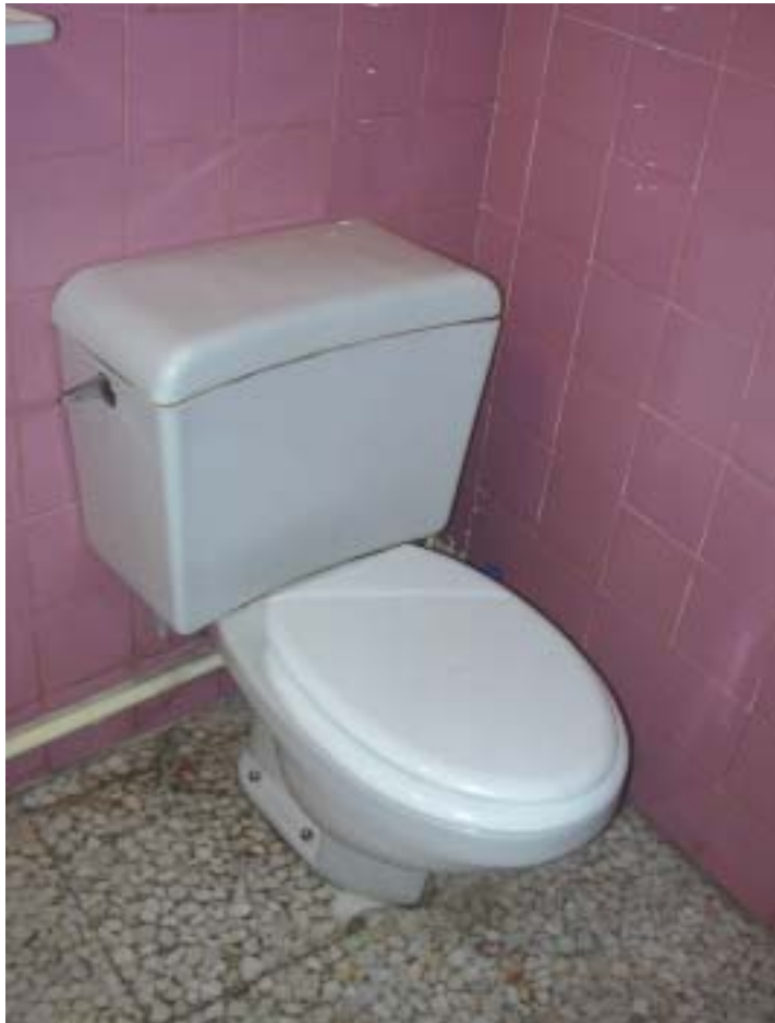
Inodoro con una cisterna de mochila antigua, de 20 litros de capacidad (Foto Santiago Campos).
