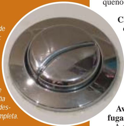
Pulsador de interrupción voluntaria. Requiere pulsar una segunda vez para detener la descarga.
