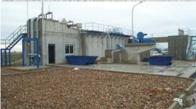
Construcción de la estación depuradora en El Rocío.
