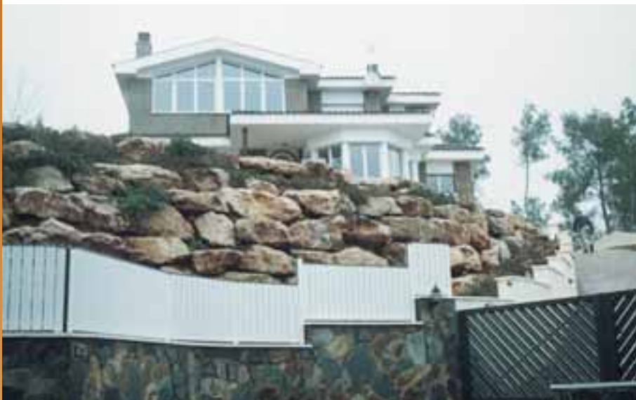
Vivienda unifamiliar con sistema de reutilización de aguas grises en Corbera de Llobregat (Barcelona).
