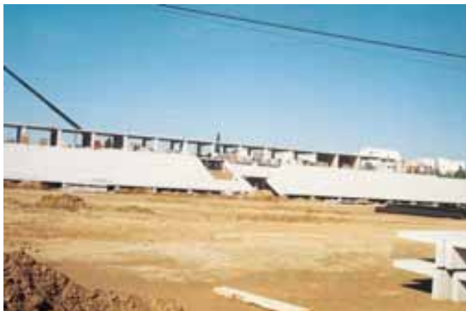
Construcción de campo de fútbol en Vilanova i Geltrú (Barcelona), donde se instaló un sistema de aprovechamiento de aguas grises y pluviales.
