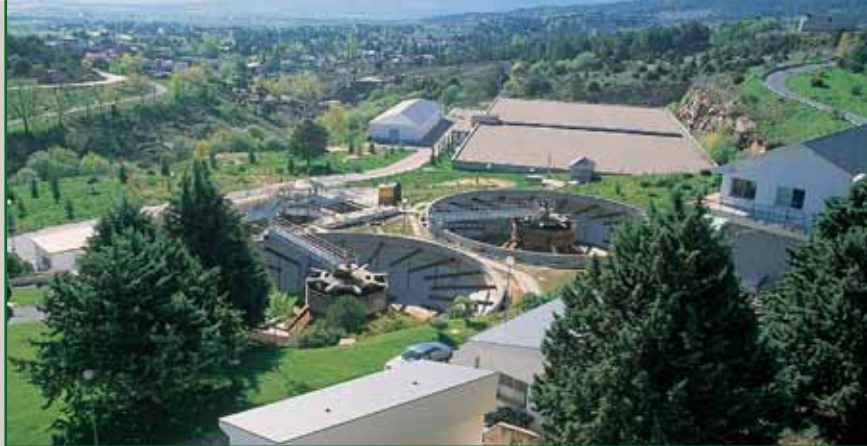
La purificación del agua y el tratamiento de las aguas de desecho se considera insuficiente y por tanto supone una merma de la calidad del agua. Foto: Vicente González.
