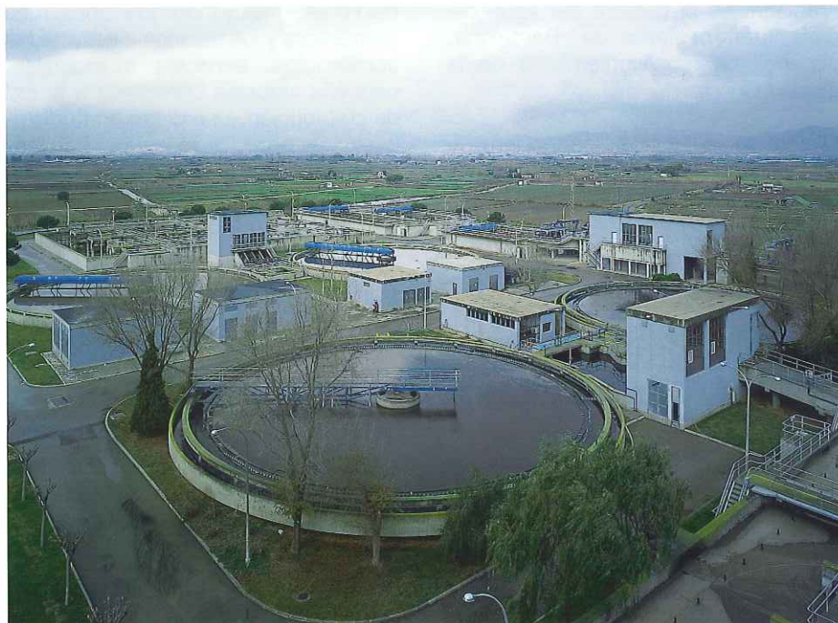
■ Interior de la depuradora de Gavà. Foto: Frederic Camallonga.
