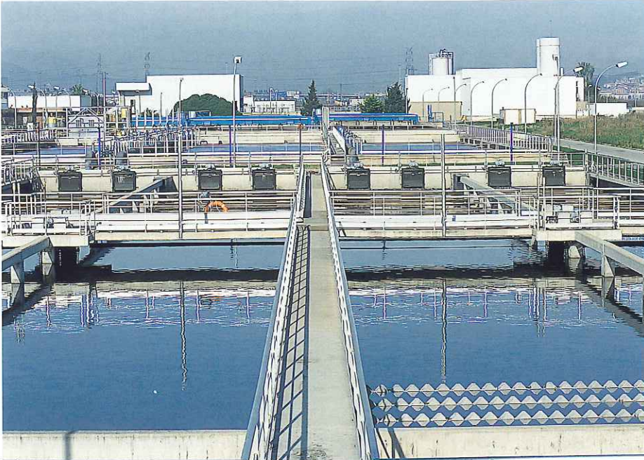
■ La dotación de agua por habitante se aproxima en Barcelona a 300 l/hab/día. Foto: Frederic Camallonga.
