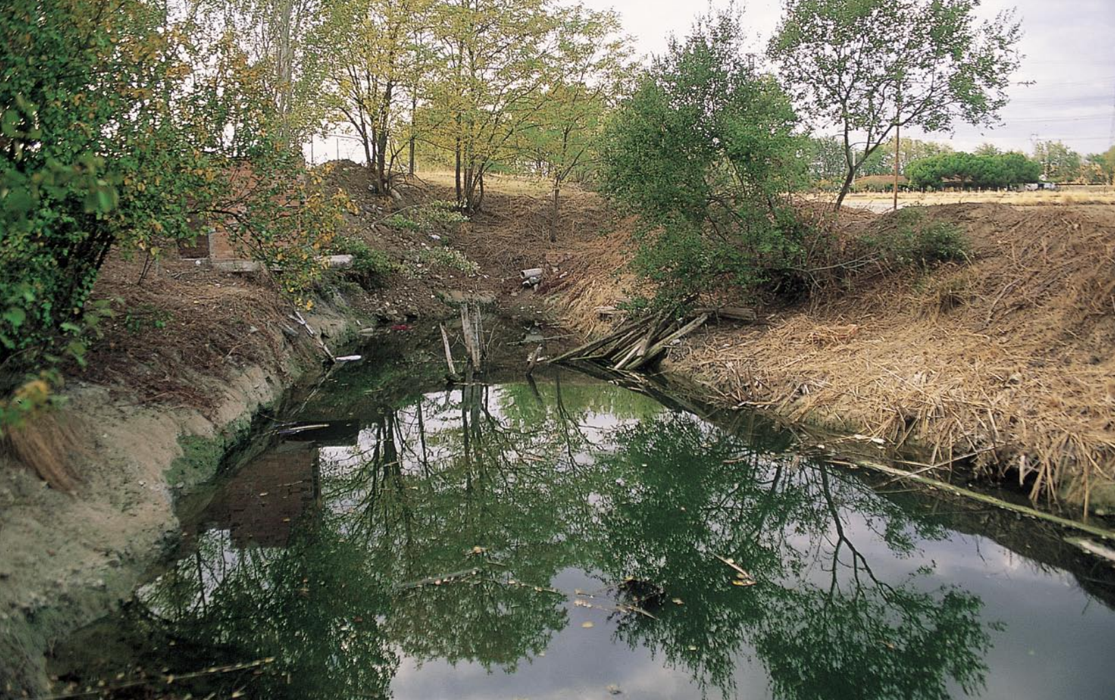
Obras de restauración ecológica en Arroyo Quiñones. S. Sebastián de los Reyes Foto: Luis Merino. Naturmedia
