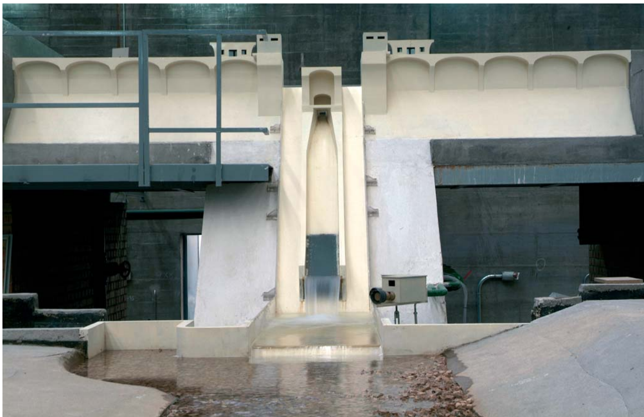
Aliviadero y desagüe de fondo de la presa de Castrovido (Burgos).
