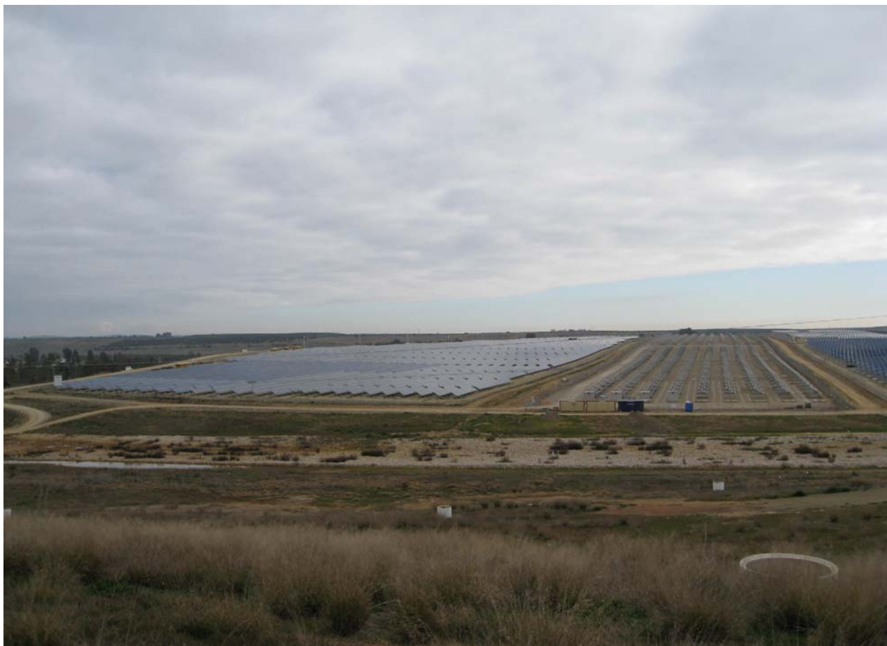
Paneles solares instalados en las cercanías de la antigua balsa.
