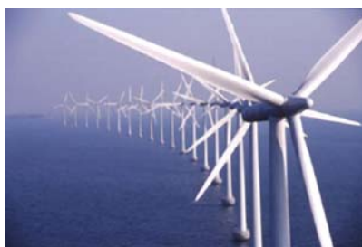
Parque eólico de Kentish Flats. 90 MW (Vattenfal. Gran Bretaña). Fase de Montaje.
