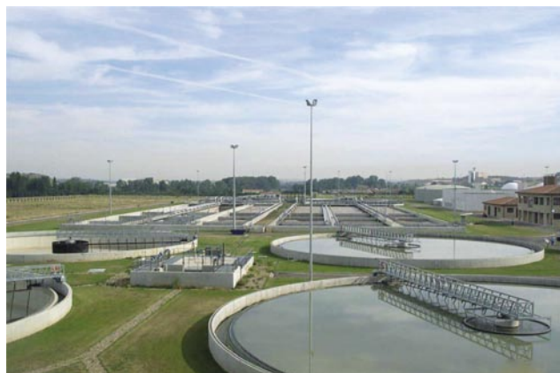
Estación Depuradora de Aguas Residuales de Salamanca. Foto MMA
