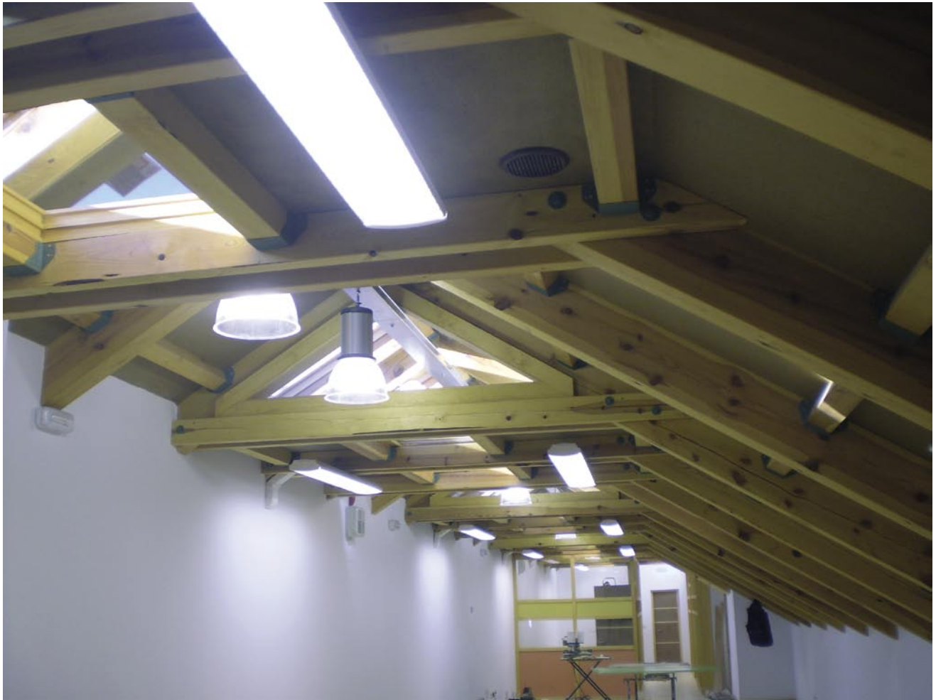
Rehabilitación de edificio con criterios de sostenibilidad.
