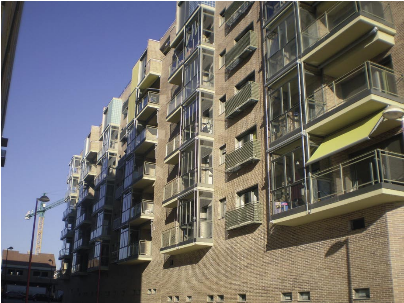
Invernadero como elemento de captación y sistemas de protección. Viviendas bioclimáticas en el polígono El Bercial de Getafe.
