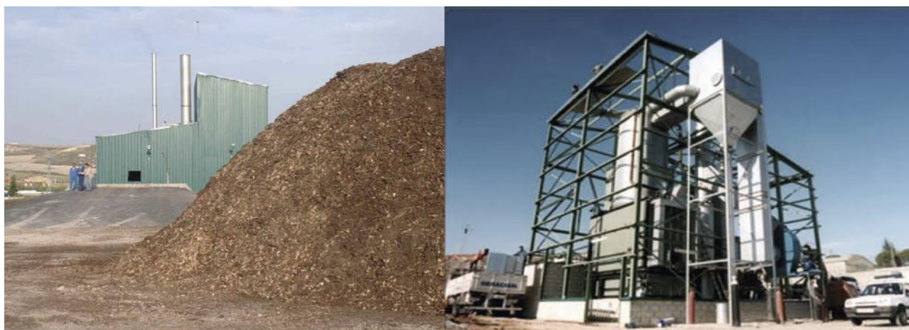
Central de calefacción centralizada alimentada con biomasa en Cuéllar ( Segovia).
