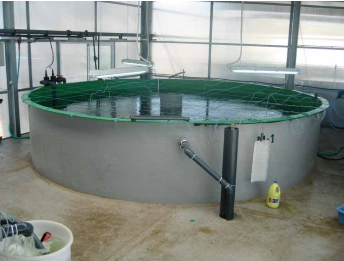
Figura 7. Uno de los tanques de cultivo larvario utilizado por el IEO.
