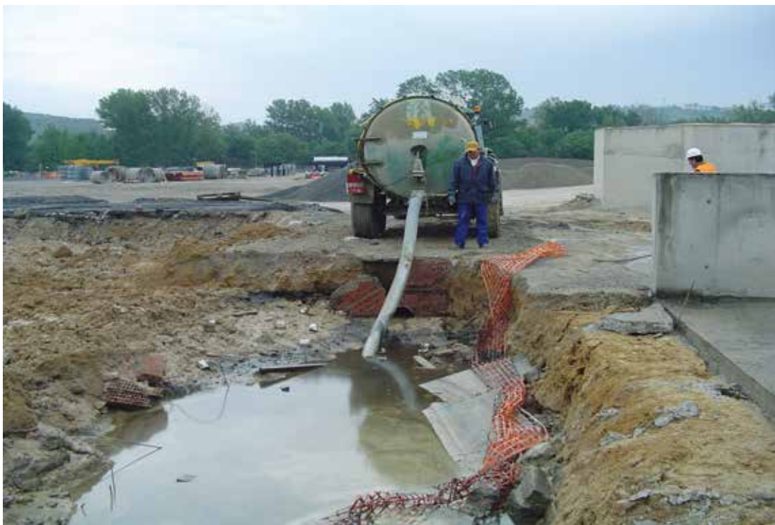
Retirada de agua contaminada en una obra.
