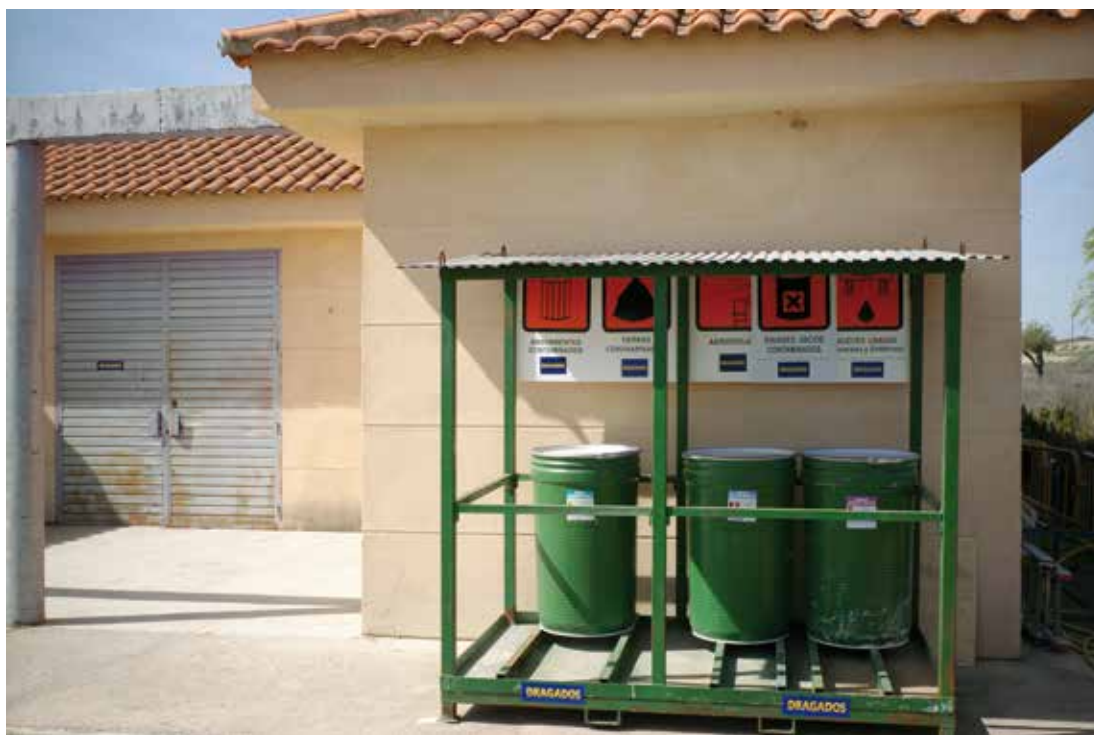
Punto limpio para depositar residuos peligrosos.
