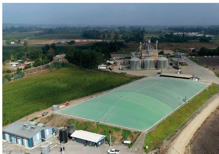
Figura 3: Balsa de purines antes y después de ser cubierta para evitar emisiones de \text{NH}_3 y recuperar \text{CH}_4 para su uso energético. Fotos del autor (arriba) y de Agrícola AASA, Chile (abajo).
