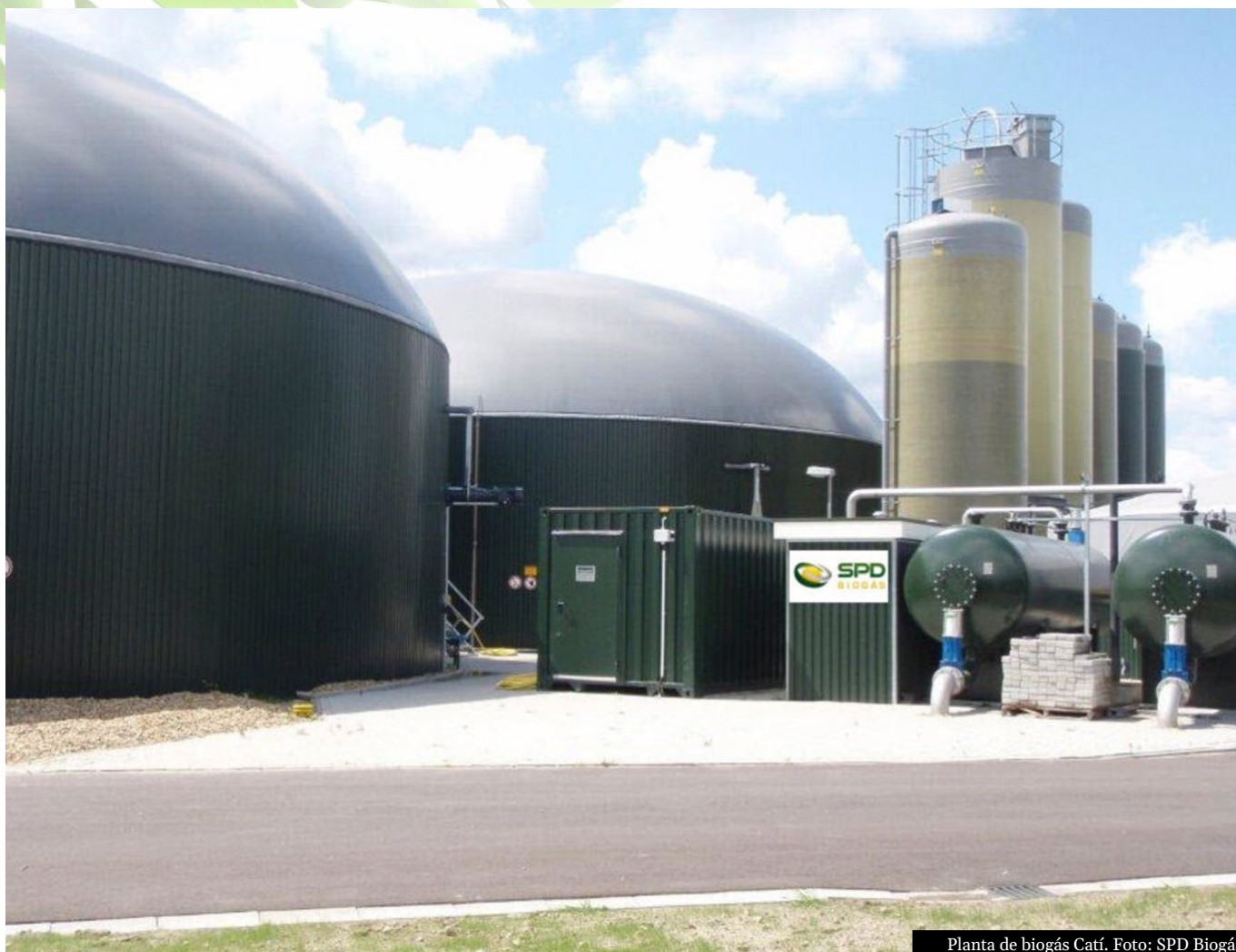
Planta de biogás Catí. Foto: SPD Biogás
