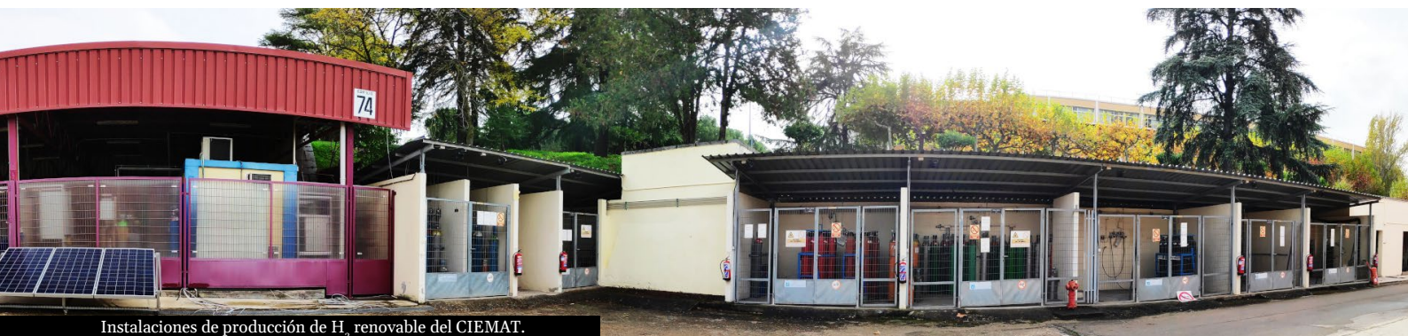
Instalaciones de producción de H 2 renovable del CIEMAT.
