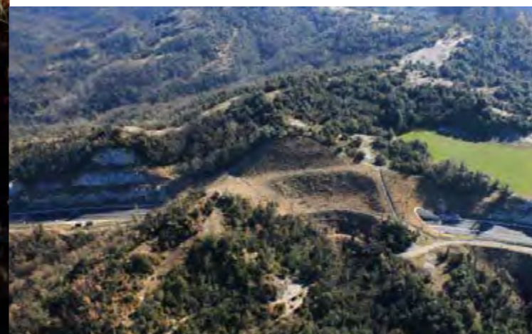
Los pasos de fauna son fundamentales para evitar la fragmentación del hábitat, el aislamiento de poblaciones y la mortalidad por atropello. Vista aérea Ecoducto C-37 Cavorca © Generalitat de Catalunya
