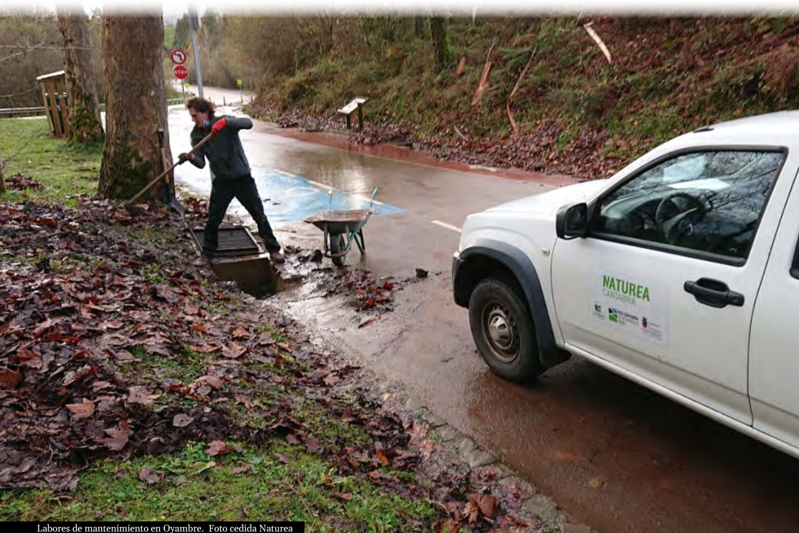
Labores de mantenimiento en Oyambre. Foto cedida Naturea
