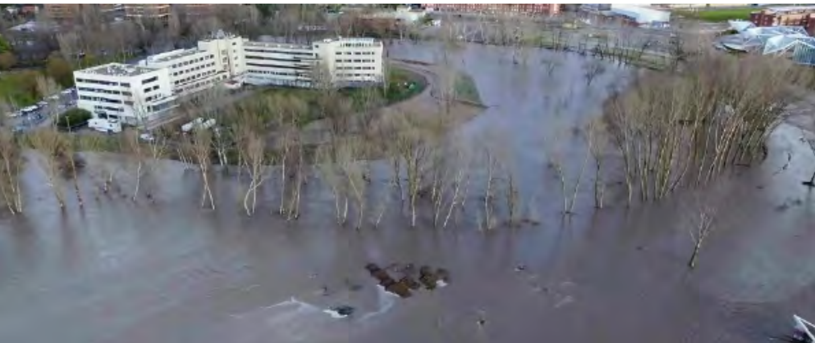
Hospital – Clínica “Recoletas de Cuenca”: Desbordamiento de las aguas por una avenida del Júcar en diciembre de 2019. La movilización de la mota existente entre el cauce y el complejo hospitalario evitó que el agua alcanzara el edificio.
