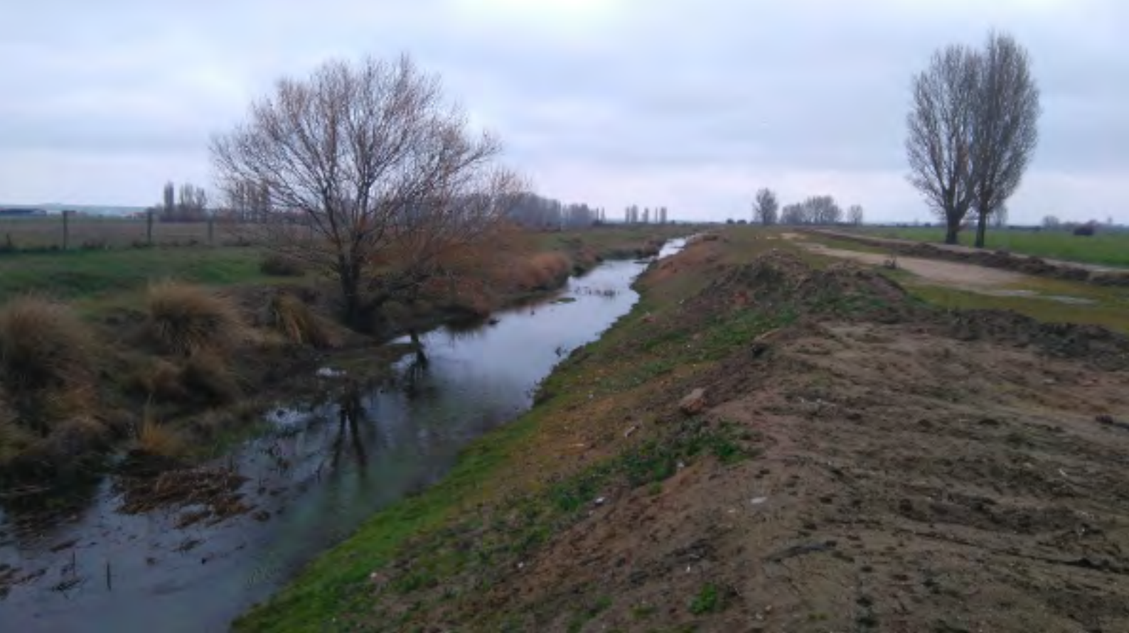
Mota (río Arevalillo, Albornos). Las motas canalizan los cauces e impiden la laminación de las avenidas en las llanuras aluviales.
